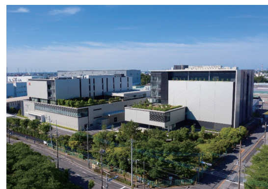
埼玉県春日部市 開発センター／生産センター
